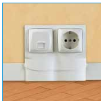
Marco doble Oteo, montaje horizontal sobre la canal
