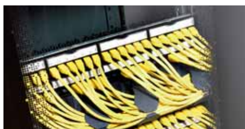
Panel de conexión 19"
